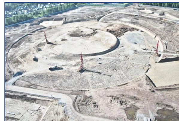
Строительная площадка «СКИФ», июнь 2022 года
