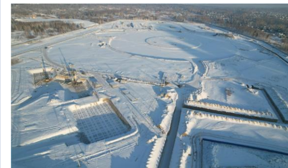
Строительная площадка «СКИФ», декабрь 2022 года
