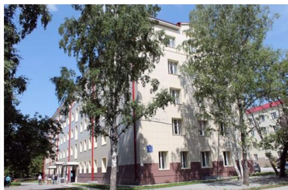
Дом на проспекте Строителей 11
