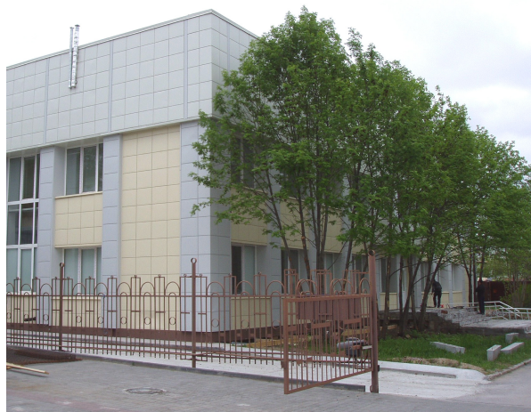
Рис. 8. Корпус-модуль МТЦ СО РАН после комплексного капитального ремонта
