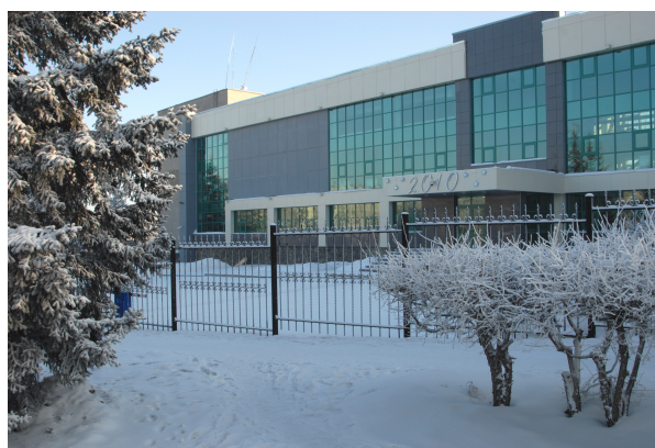
Рис. 9. Корпус общего назначения ИСЗФ СО РАН после комплексного капитального ремонта
