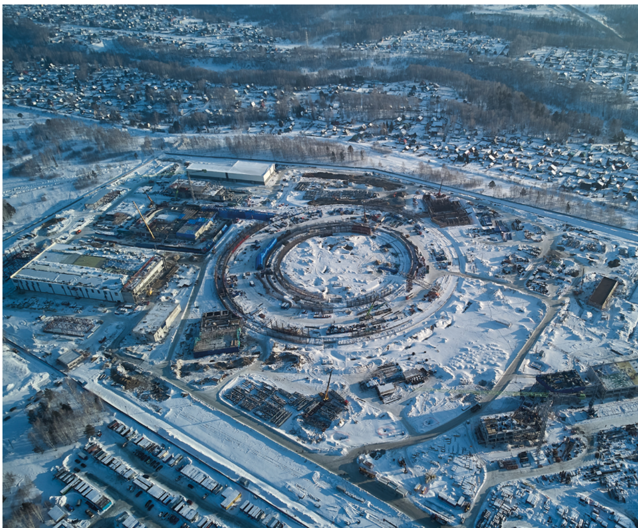
Рис. 3. Строительная площадка ЦКП «СКИФ» в январе 2024 года (Фото: Александр Ощепков, НГС Новости)
