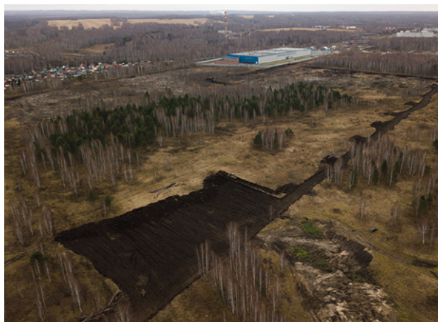
Рис. 1. Строительная площадка ЦКП «СКИФ» в октябре 2021 года
