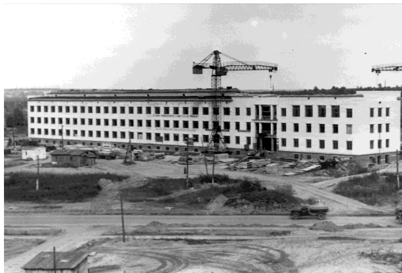
Строящийся главный корпус – 1959-1963 гг
